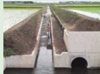
2段式水田魚道（栃木県西鬼怒川地区）
