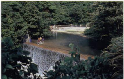
▲土砂の流出を防ぐ砂防ダム
