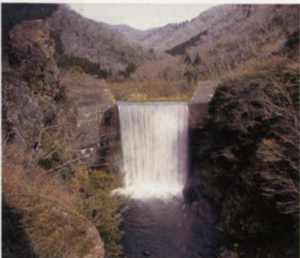
砂防ダム……土砂の流出を防いでいる
