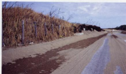
②冬の強い季節風で道路が飛砂で埋まる
